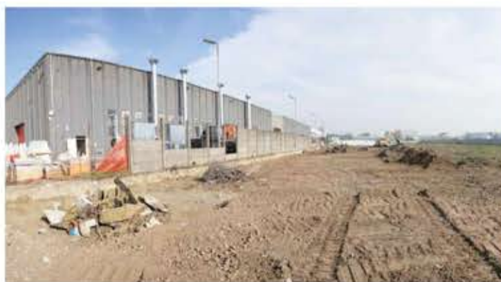
Il cantiere al porto di Cremona (Servizio Betty Poli)
